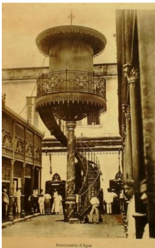
Figura 23 – Reservatório de água.
