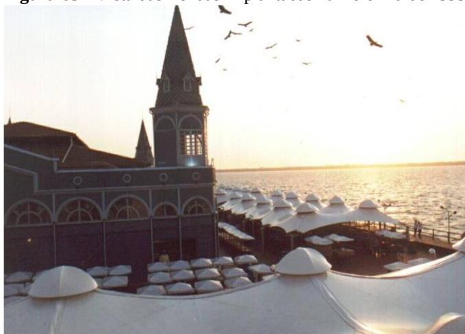
Figura 63 - Vista das Tendas implantadas na Reforma de 1999.
