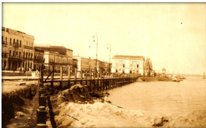
Figura 38- Foto de construção do muro de arrimo do cais, onde temos a Praça do Pescador
