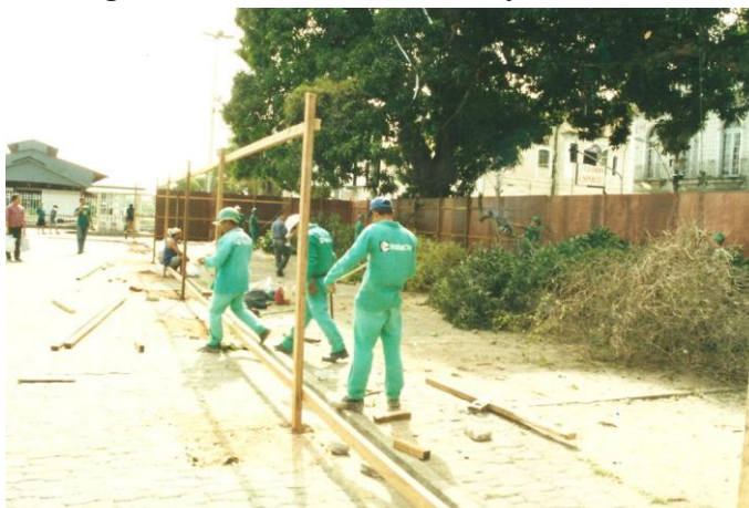
Figura 60 - Reforma na área da Praça do Pescador.
