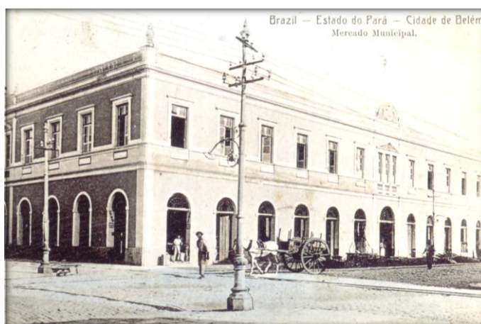
Figura 20 - Mercado Municipal após conclusão da Reforma.
