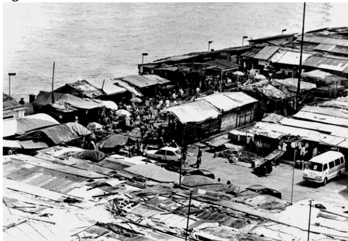
Figura 56 - Vista aérea do Ver o Peso antes da reforma de 1999.
