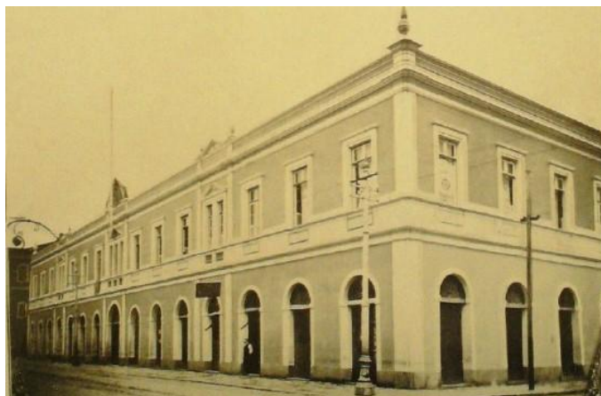
Figura 18 - Fachada do Mercado Municipal.
