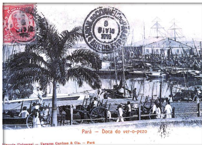
Figura 26 - Espaço da Doca do Ver o Peso antes da construção do Mercado de Ferro
